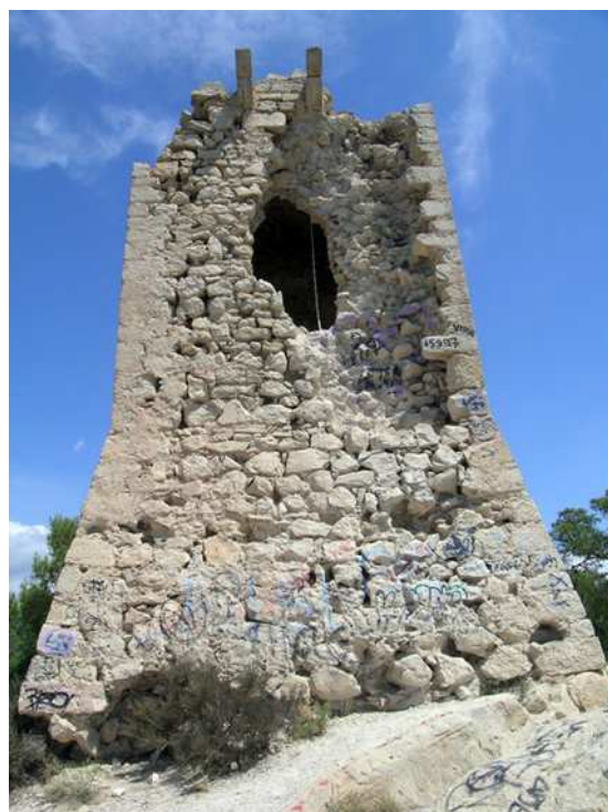
Vista del exterior de la Torre de Aguiló
