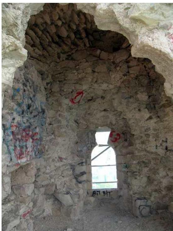
Vista del interior de la Torre de Aguiló
