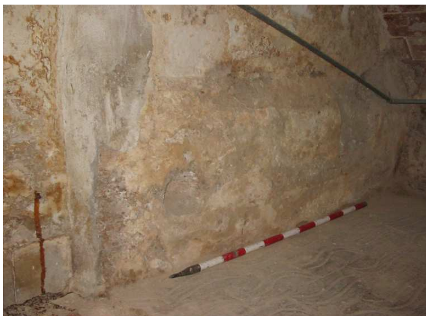
Base de la torre de la muralla localizada en la documentación muraria
