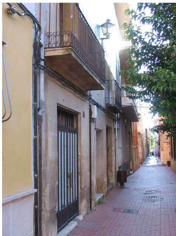
Vista de la fachada de la plaza Cardenal Ferriz, 5
