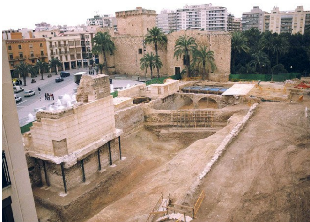
Vista general del solar con el fosó y el lienzo de muralla
