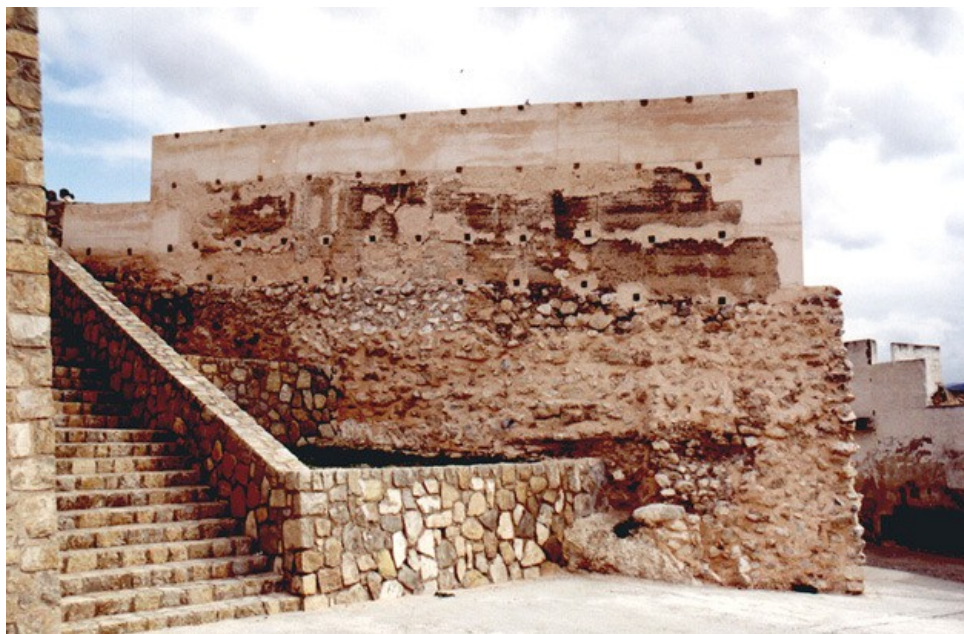
Tramo 2. Alzado tras la consolidación
