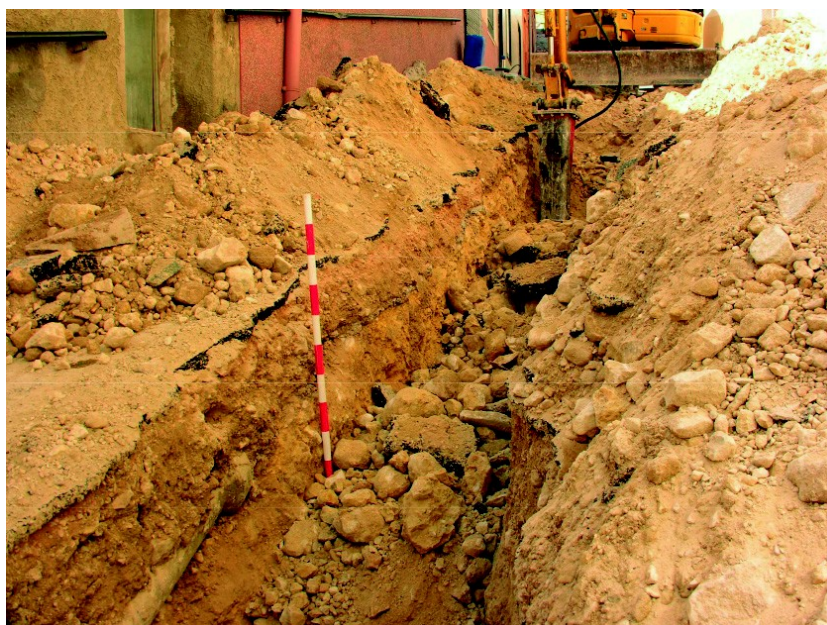
Zanja en la calle Altico. En el perfil izquierdo se observa el alcantarillado antiguo
