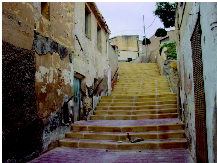
El mismo tramo de la calle Altico-tramo 2 finalizada la remodelación
