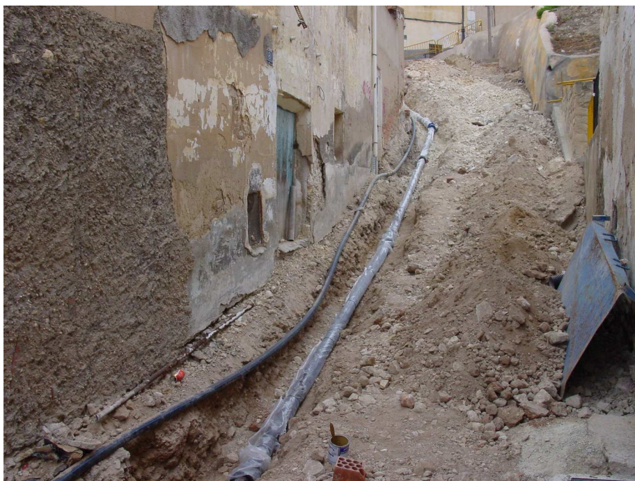
Tramo de la calle Altico-tramo 2 con la instalación del agua potable
