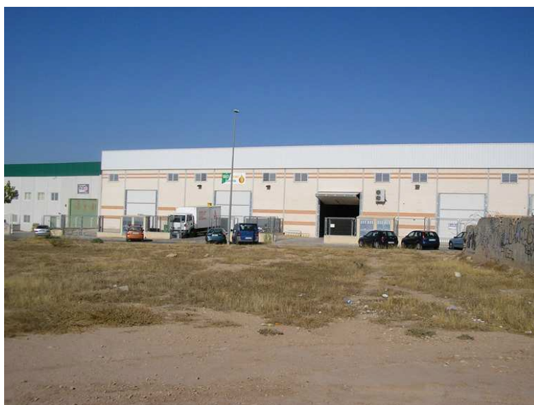
Vista general de la parcela ya edificada
