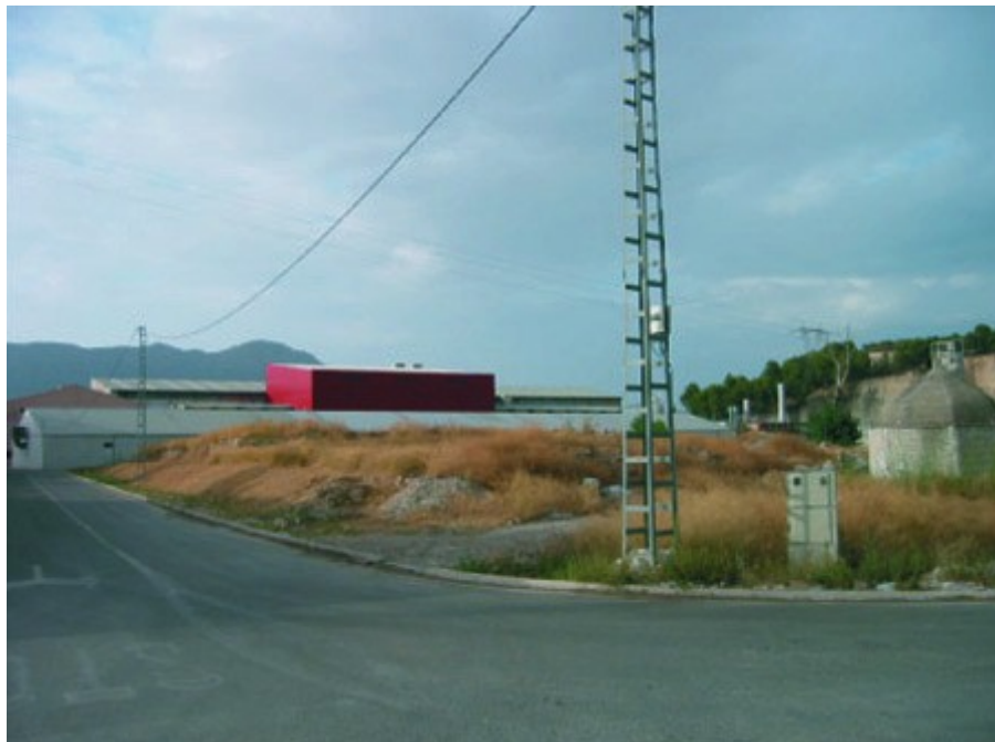
Vista general de la parcela B
