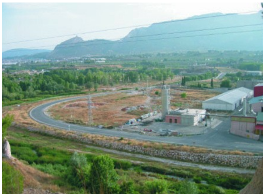
Vista general del área de intervención
