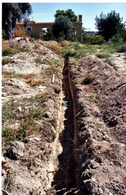
Zanja efectuada en la parcela
