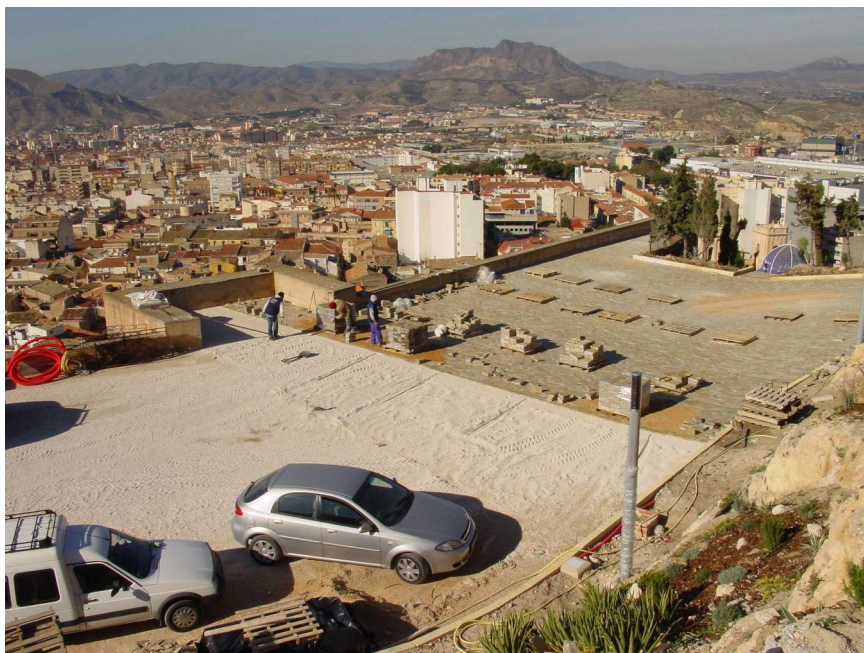
Colocación del pavimento de piedra en la explanada del castillo
