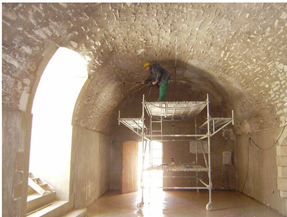
Decapado con chorro de agua de la pintura de la sala noble del castillo
