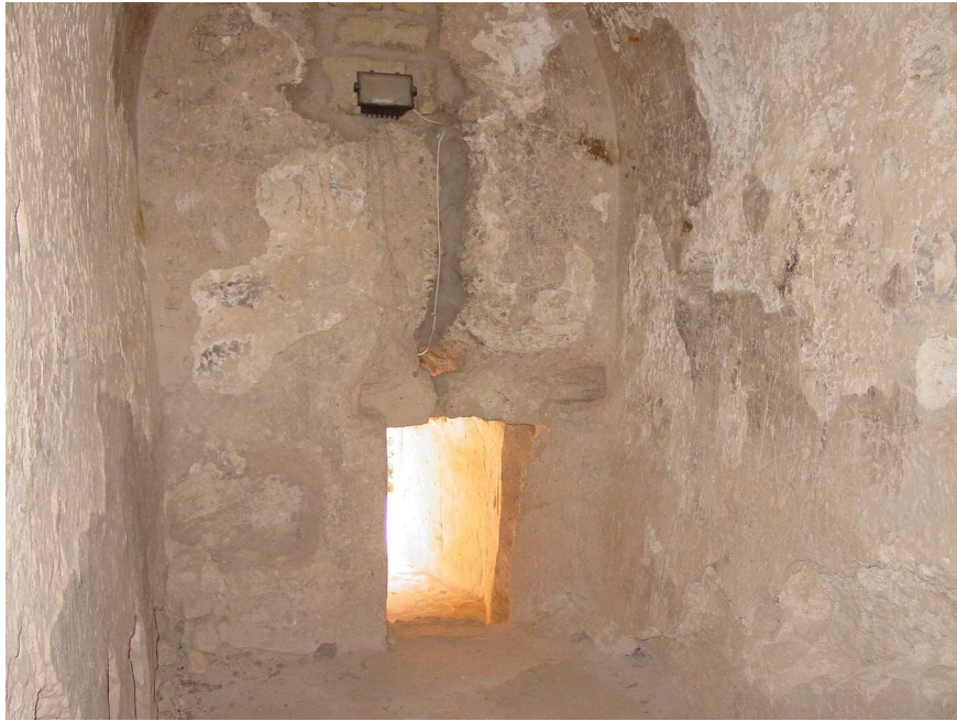
Interior del calabozo de la torre antes de la restauración
