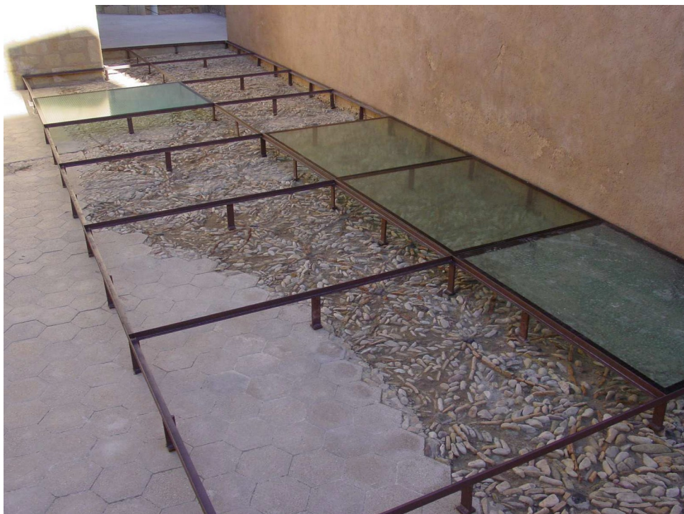
Proceso de colocación del cristal para proteger el pavimento de guijarros bajomedieval
