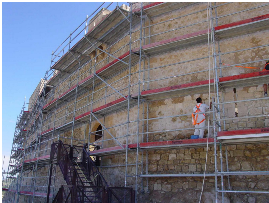
Limpieza y rejuntado de las murallas del castillo
