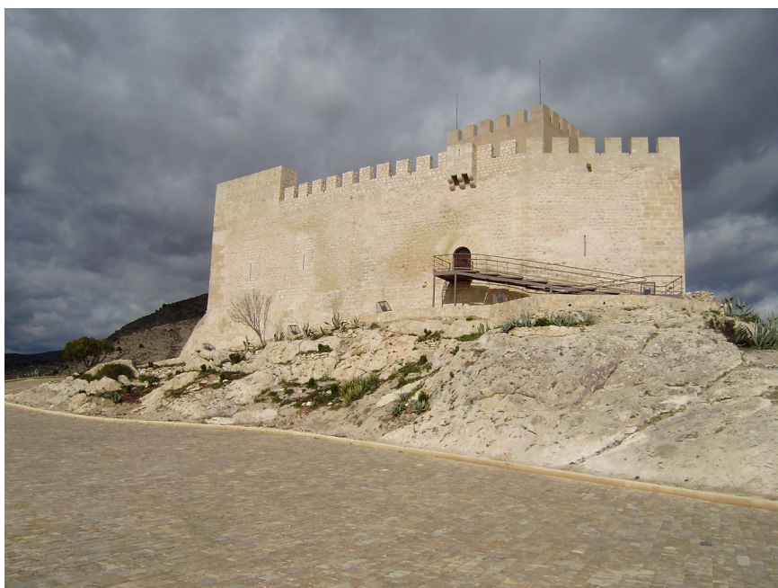
Explanada y exterior del castillo tras la restauración
