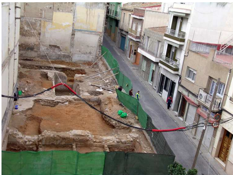
Vista general de la planta del solar excavado
