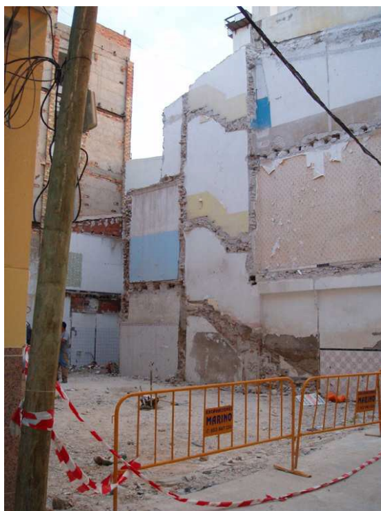
Vista del solar tras el derribo de la vivienda existente
