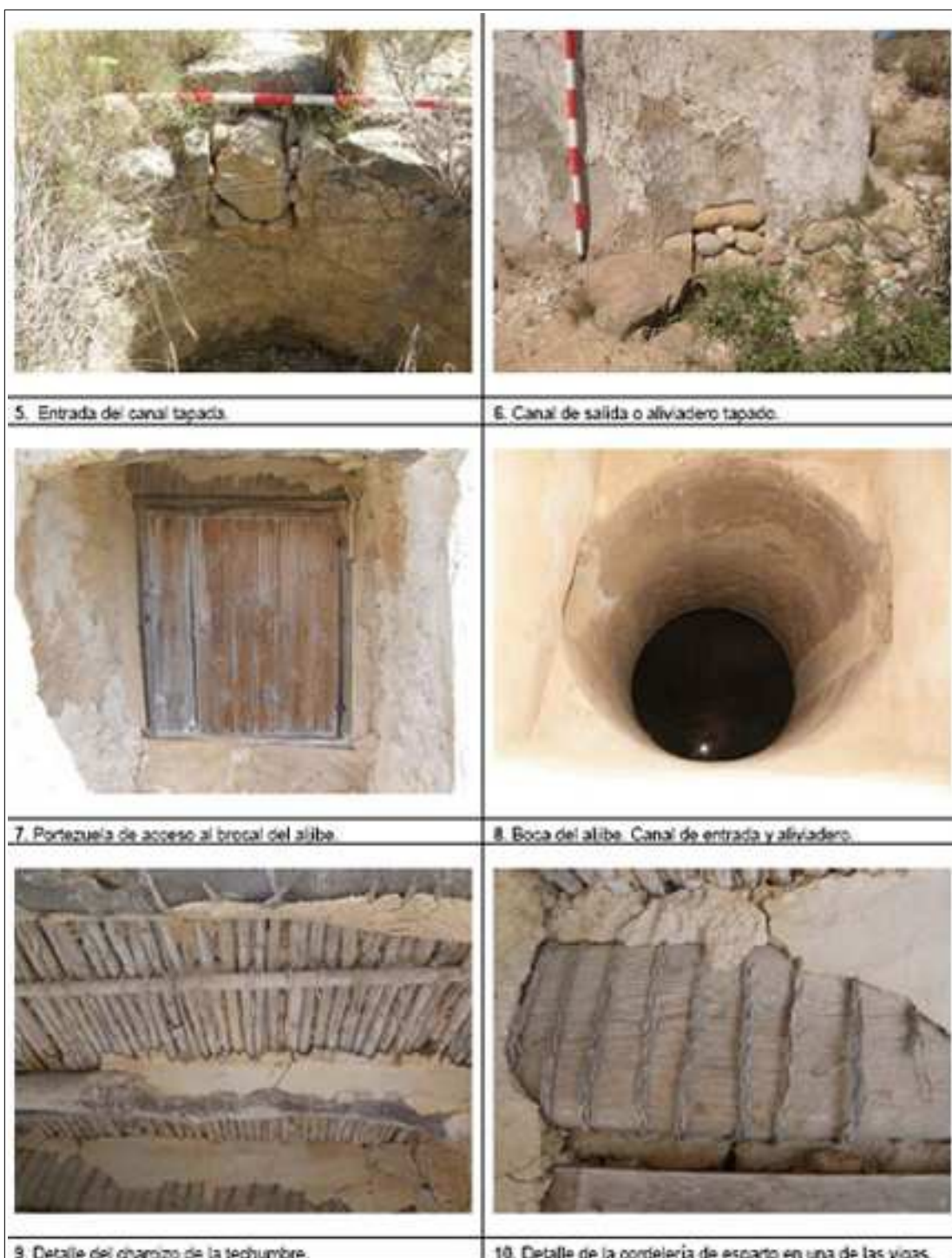
Fotos de detalle del aljibe Casa de Oros (Orihuela)
