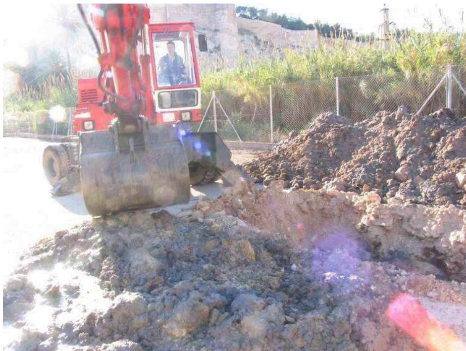
Detall de l'excavació d'una rasa amb màquina
