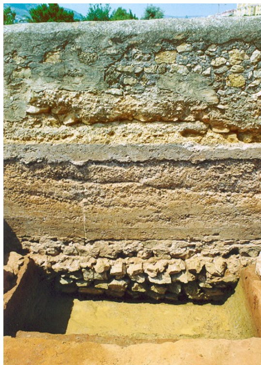
Basament de la muralla. Sondeig
