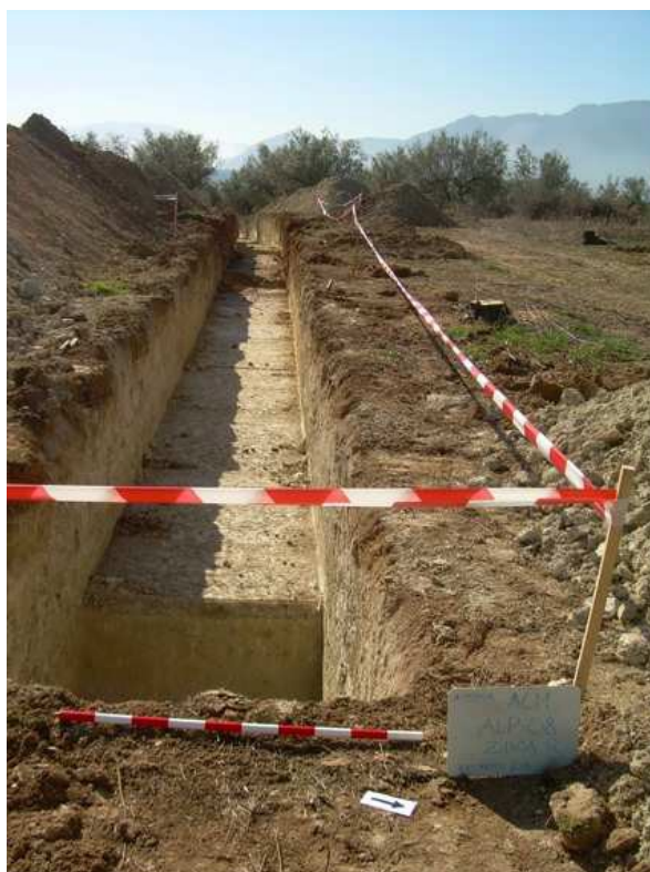
Vista del Sondeo 8
