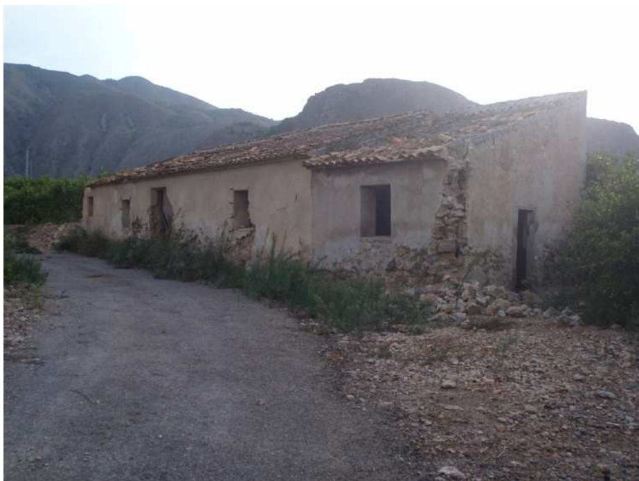
Casa de campo Las Majadas I
