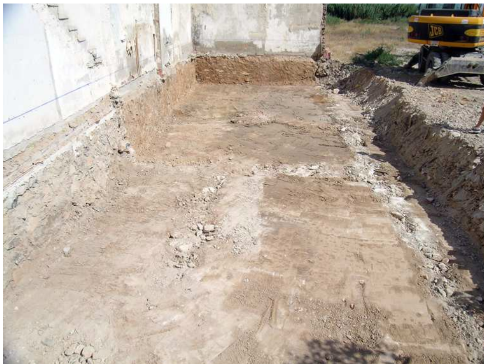
Vista del solar excavado
