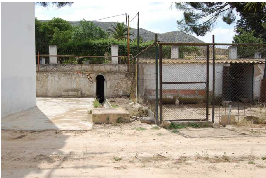
Edificaciones anexas a la vivienda rural localizada
