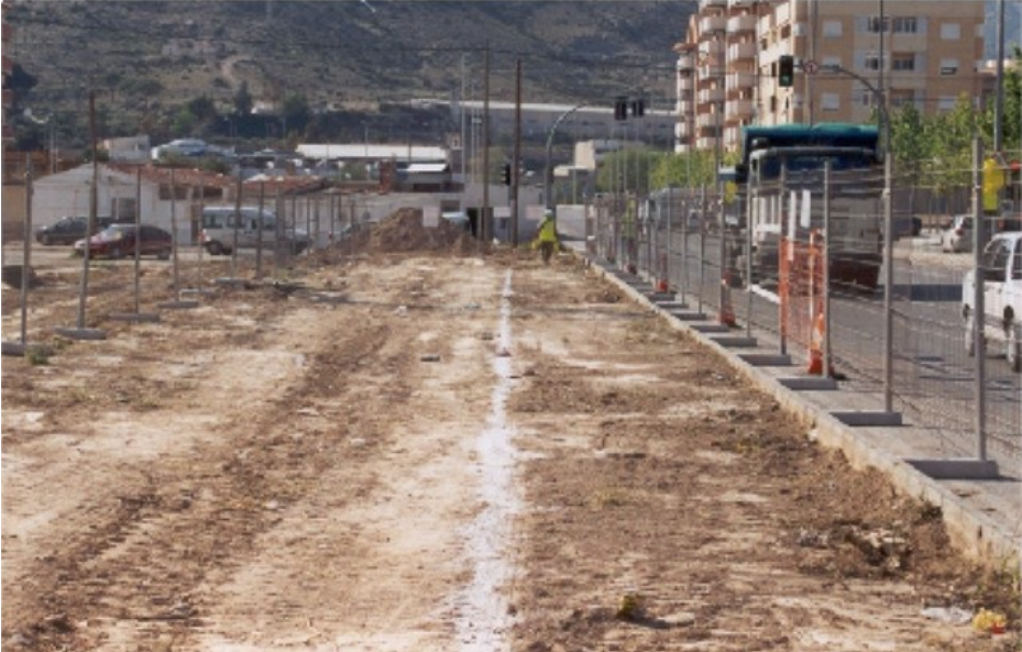
Vista de la zona antes del comienzo de los trabajos
