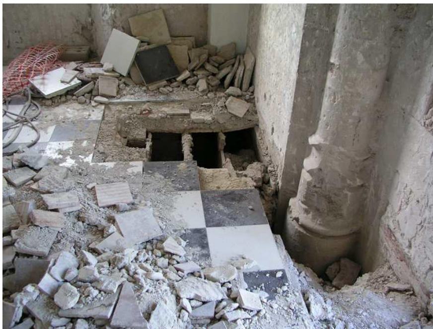
Tabiques sobre las bóvedas del ángulo NW
