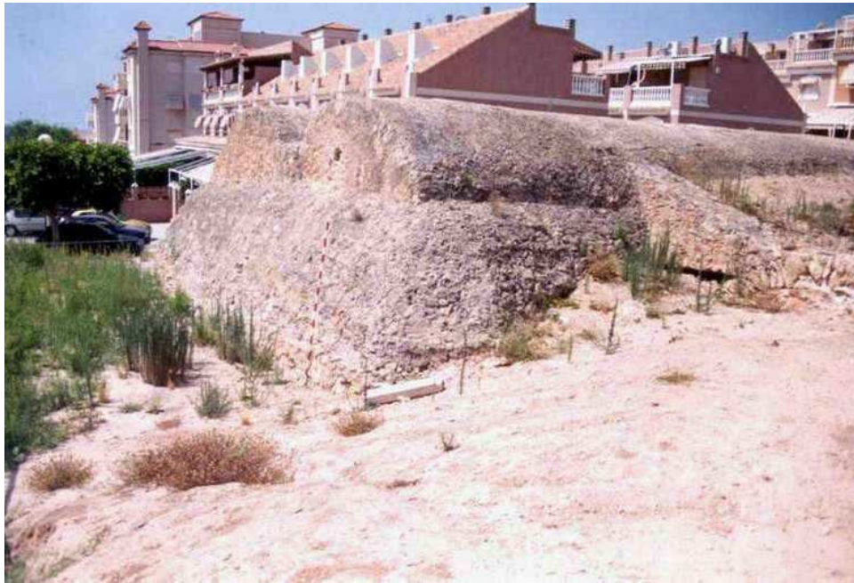
Vista de los aljibes antes de la intervención
