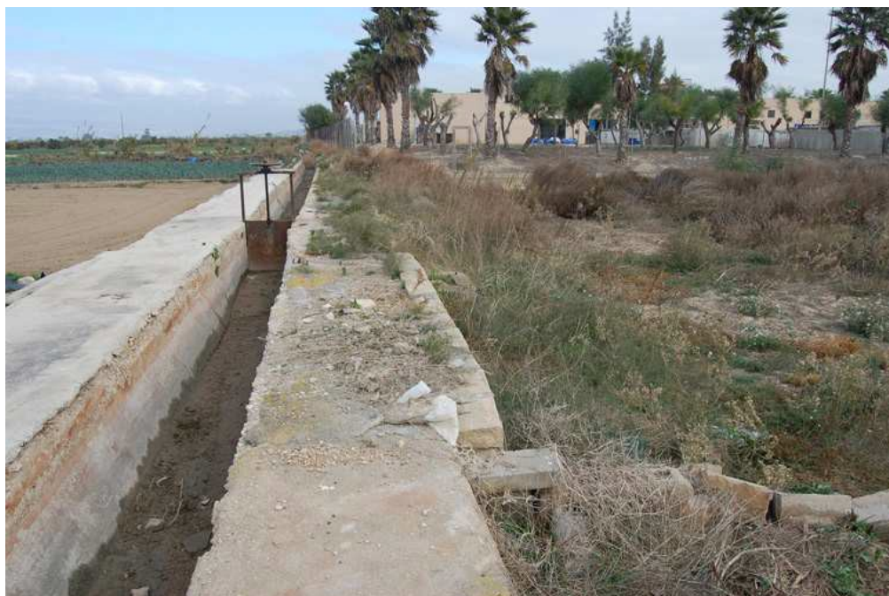
Vista parcial del área de intervención II
