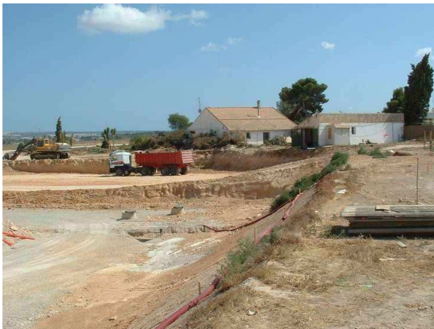
Vista general de las obras de ampliación
