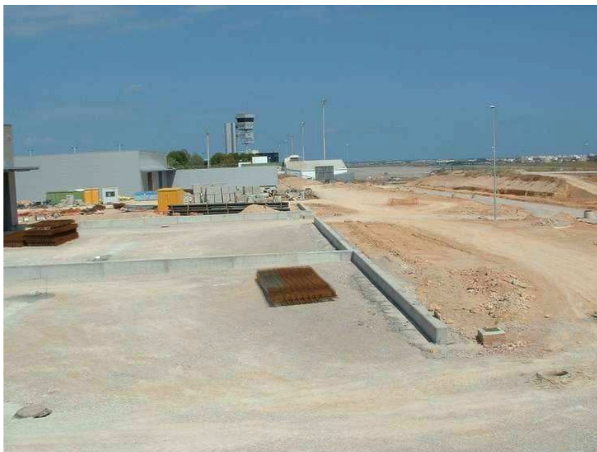
Vista de la obra de ampliación del aeropuerto
