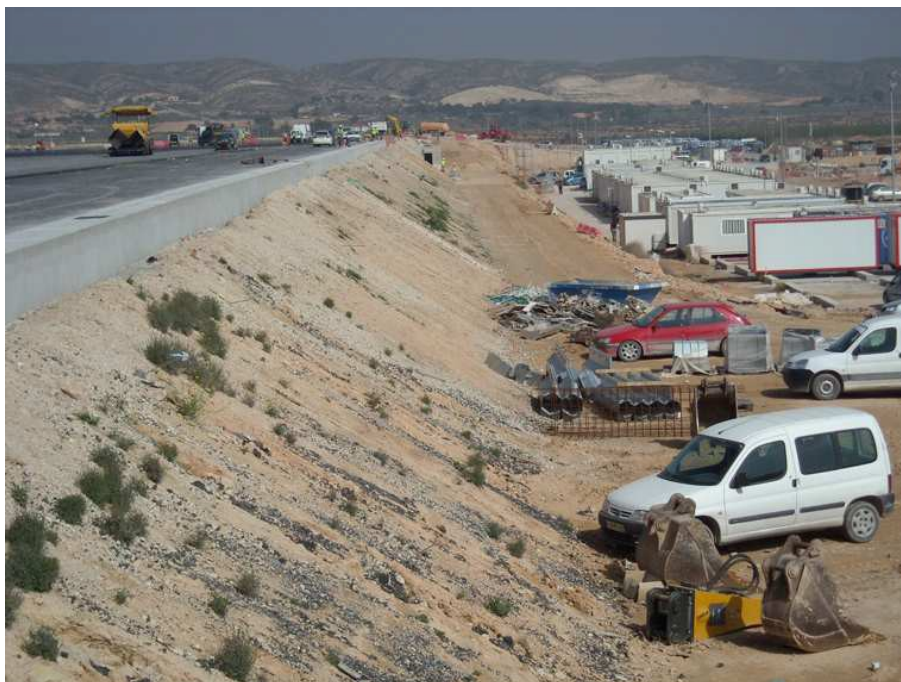
Aportes de tierra del Sector I
