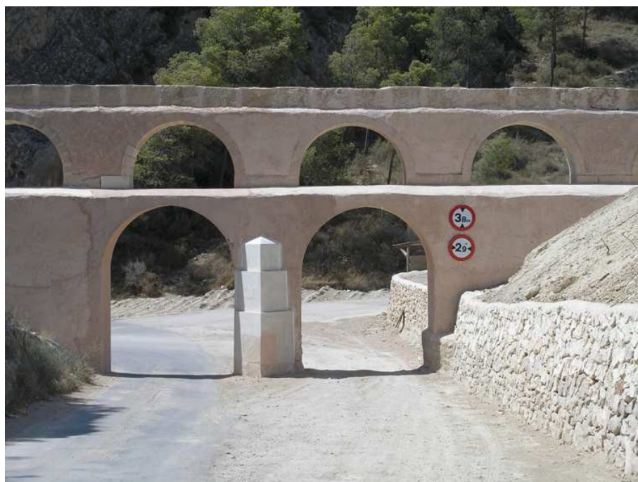
Aspecto del acueducto al término de los trabajos
