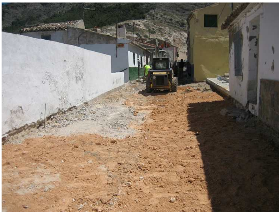
Vista parcial del área de intervención
