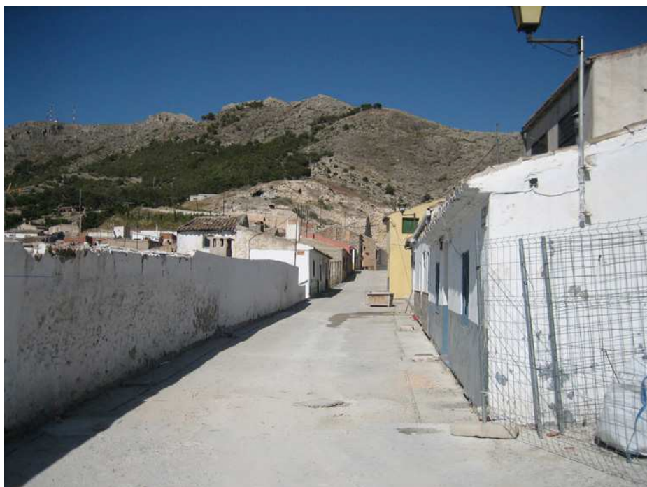
Vista parcial del área de intervención
