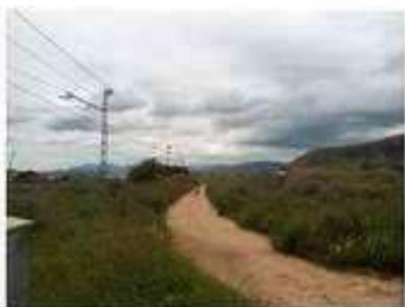
Foto 9. Vista del trazado desde el P.K. 54.750 hacia el Oeste.
