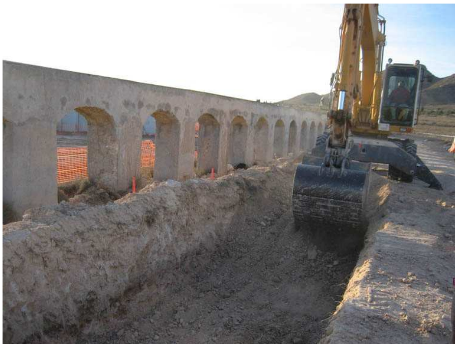
Obra de ingeniería para la protección del Canal de los Belgas
