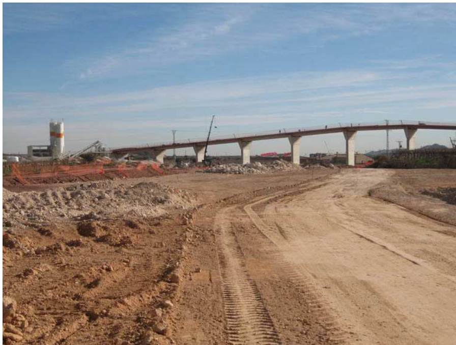
Viaducto p. k. 502
