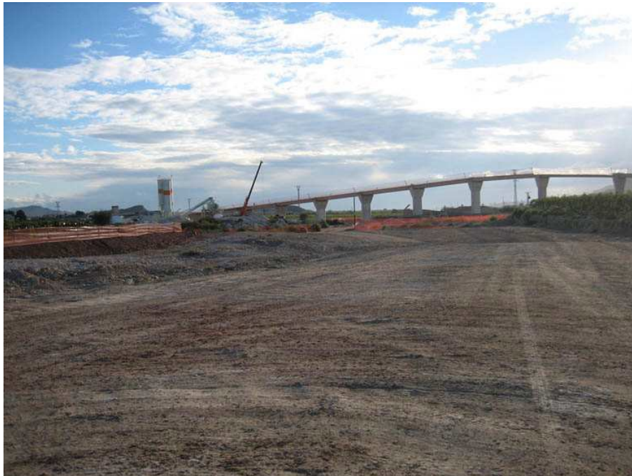
Vista de una de las zonas de traza desbrozada con un viaducto al fondo
