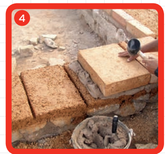
4 Recreido del muro.
