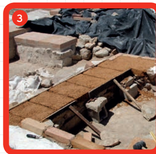
3 Proceso de encapsulado de los adobes.
