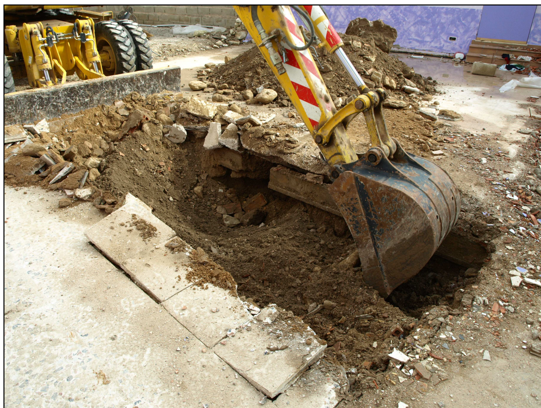
Vista de la apertura del sondeo 2.
