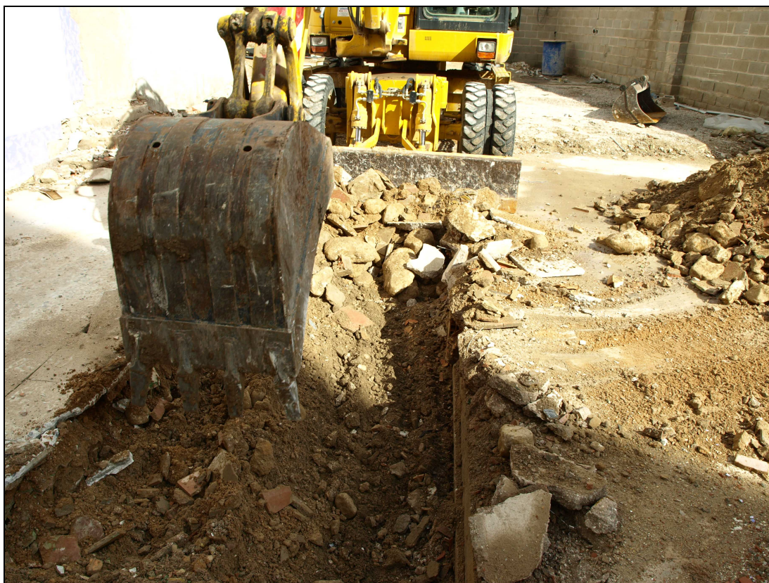
Vista de la apertura del sondeo 1.
