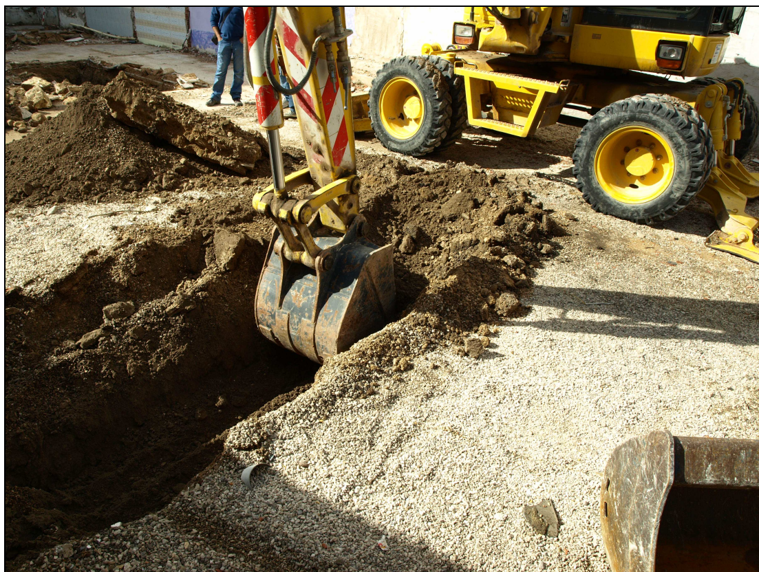
Vista de la apertura del sondeo 3.
