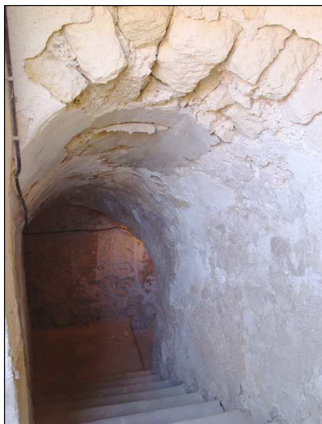
Detalle de la técnica constructiva de la bóveda de cubierta.
