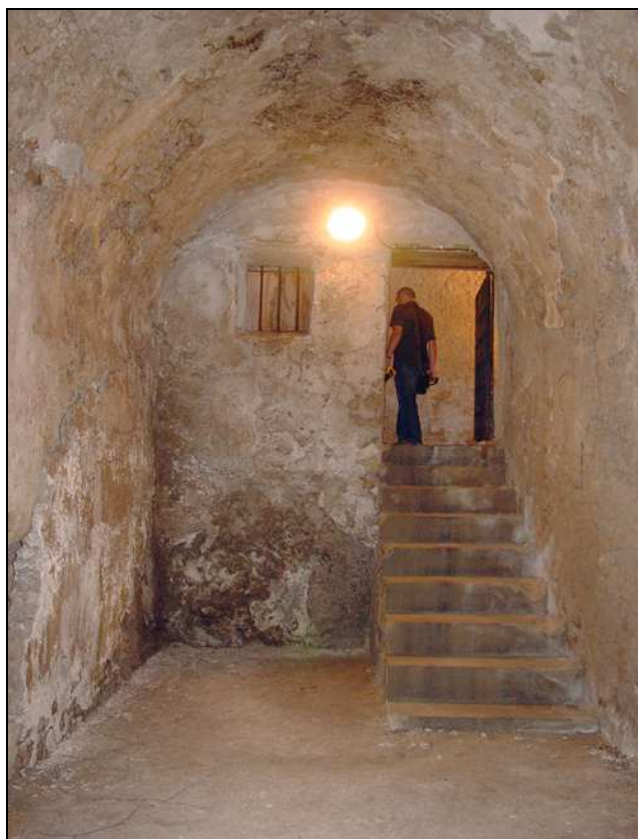
Aspecto del calabozo al iniciar la intervención.
