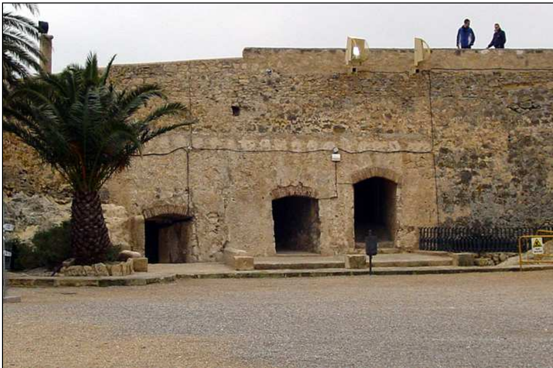
Vista de la fachada de las salas de la Mina.
